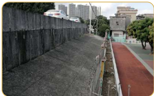
攀爬区改造前无法使用
