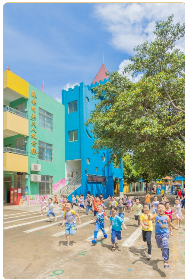
伦教霞石幼儿园在德胜基金会的资助下，率先完成了洗手间改造、厨房升级、外墙翻新，幼儿园基础设施和环境得到改善。
